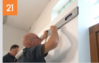
Montage des Wandanschlussprofils
