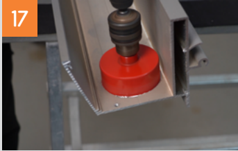
Montage des Laubfangsiebes in das Rinnenprofil
