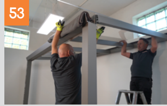
Montage der Dacheindeckung
