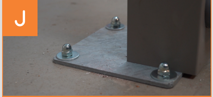
Pfosten ausrichten und fixieren
