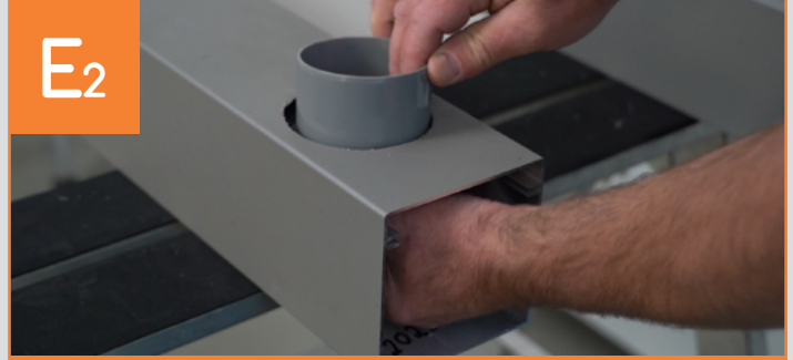
Einbau der Entwässerung in den Pfosten
