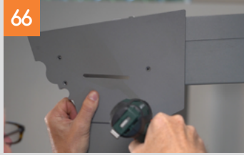
Montage der Rinnenverblendung und Seitenkappen
