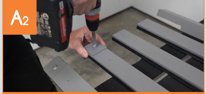
Vorbereitung der Abdeck- und Distanzprofile
