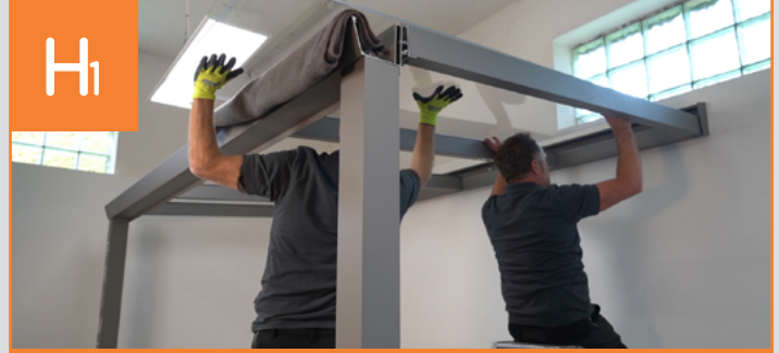
Montage der Dacheindeckung
