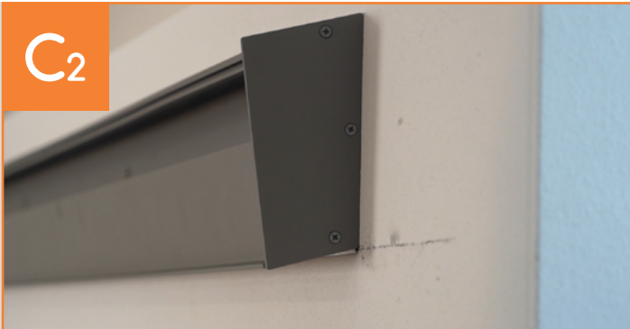
Montage des Wandanschlussprofils
