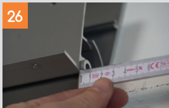
Montage des Wandanschlussprofils
