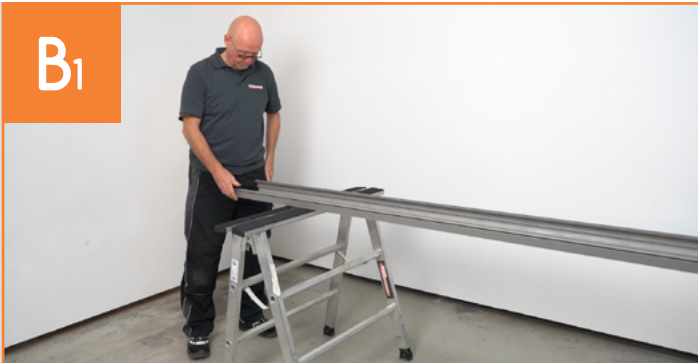
Vorbereitung des Wandanschlussprofils
