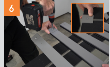
Vorbereitung der Abdeck- und Distanzprofile
