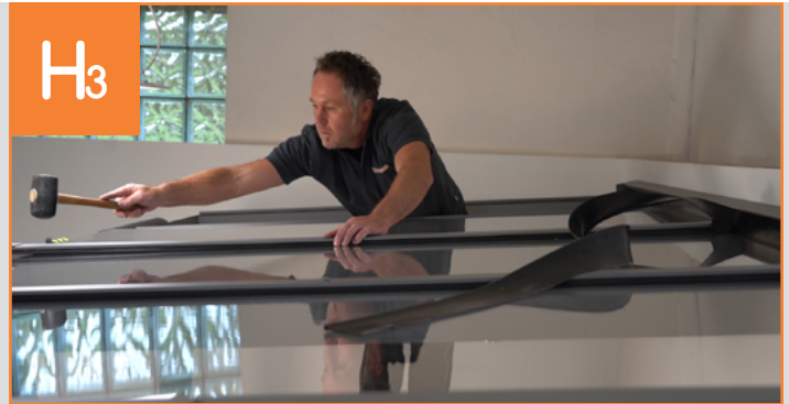
Montage der Dacheindeckung
