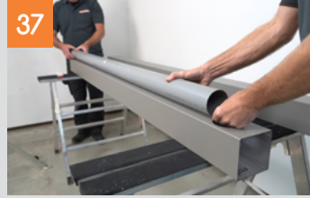
Einbau der Entwässerung in den Pfosten
