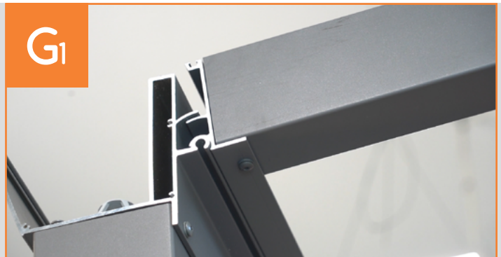
Montage der Sparrenauflage und Sparren
