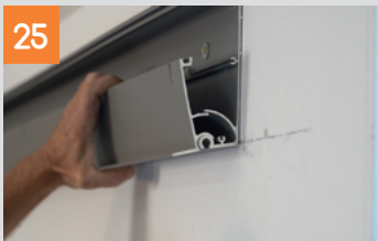
Montage des Wandanschlussprofils
