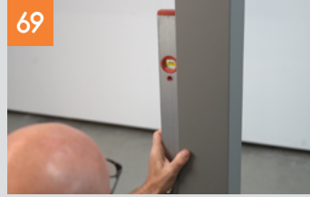
Pfosten ausrichten und fixieren
