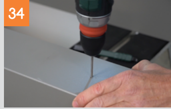
Einbau der Entwässerung in den Pfosten
