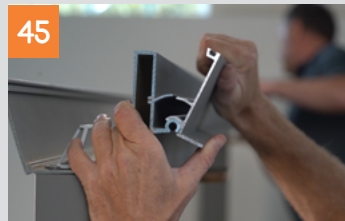
Montage der Sparrenauflage und Sparren
