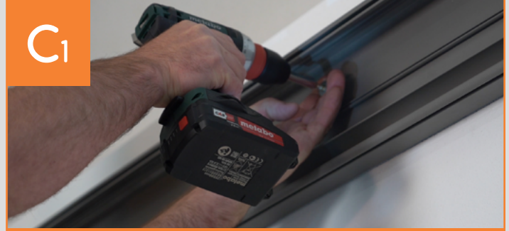
Montage des Wandanschlussprofils
