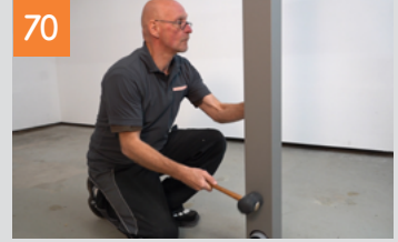
Pfosten ausrichten und fixieren
