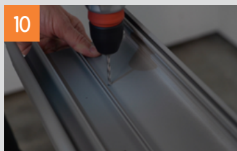
Vorbereitung des Wandanschlussprofils
