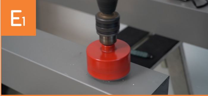
Einbau der Entwässerung in den Pfosten
