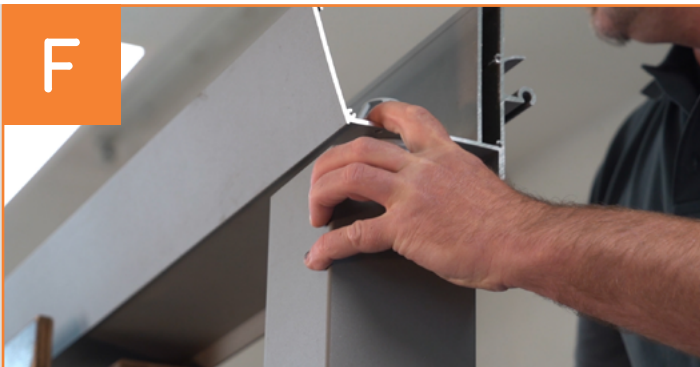
Montage der Pfosten
