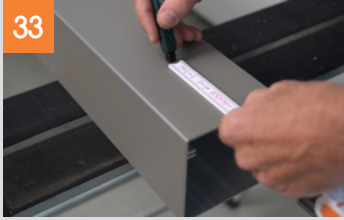
Einbau der Entwässerung in den Pfosten
