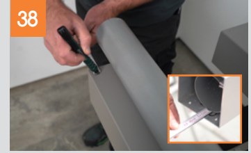
Einbau der Entwässerung in den Pfosten
