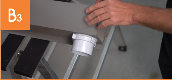
Montage des Laubfangsiebes in das Rinnenprofil
