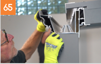
Montage der Rinnenverblendung und Seitenkappen
