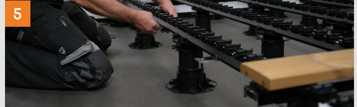
Montage des Adapters
