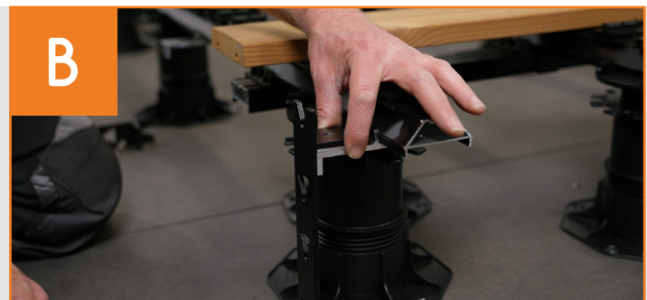
Vorbereitung der Dielen zur Seitenverblendung
