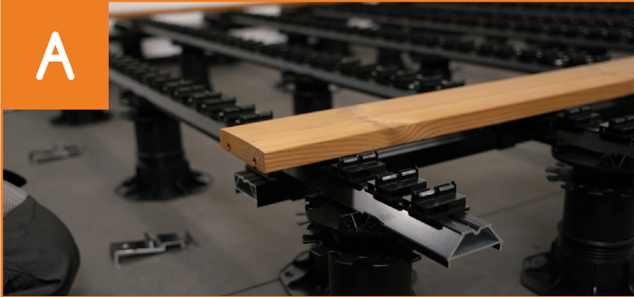
Vorbereitung der Seitenverblendung
