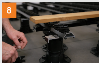
Montage des Blendenhalters
