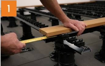
Vorbereitung der Seitenverblendung
