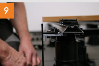
Montage des Blendenhalters
