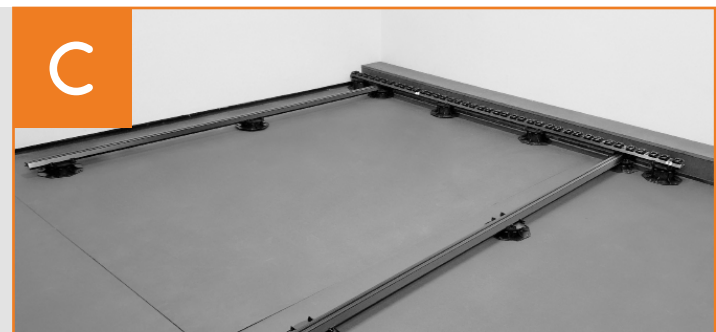
Erste Systemschiene positionieren
