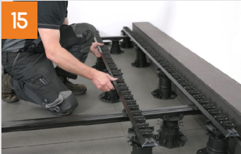
Systemschiene verlegen
