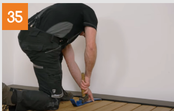
Diele herausnehmen und wieder einsetzen
