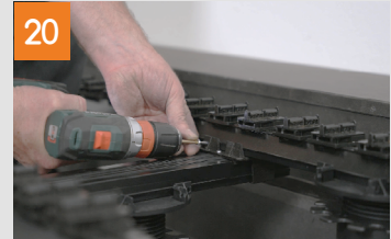
Ersten KL-Kreuzverbinder fixieren und Ausrichtung prüfen
