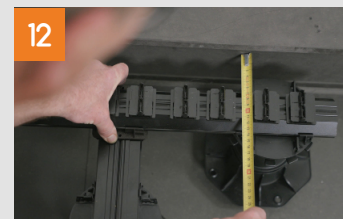
Erste Systemschiene positionieren
