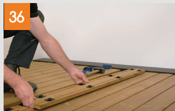
Diele herausnehmen und wieder einsetzen
