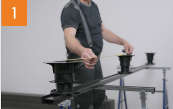
Konterlattung positionieren
