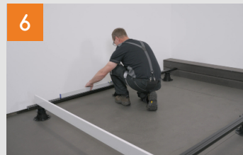
Konterlattung in Waage ausrichten
