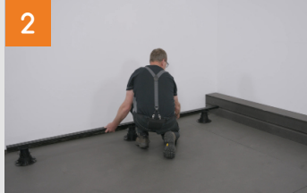
Konterlattung positionieren
