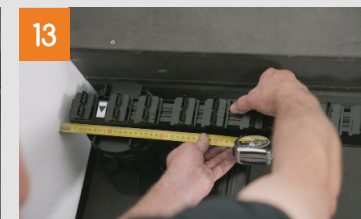
Erste Systemschiene positionieren
