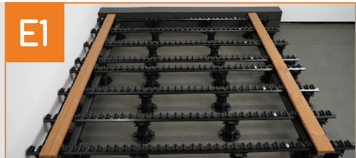
Erste und zweite Diele montieren
