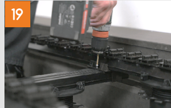
Ersten KL-Kreuzverbinder fixieren und Ausrichtung prüfen
