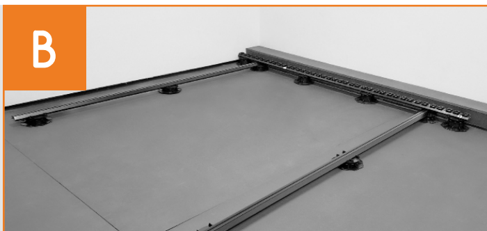
Erste Systemschiene positionieren
