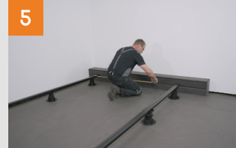
Konterlattung positionieren
