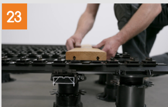
Erste und zweite Diele montieren
