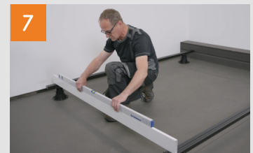
Konterlattung in Waage ausrichten
