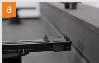
Erste Systemschiene positionieren
