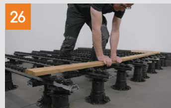
Erste und zweite Diele montieren
