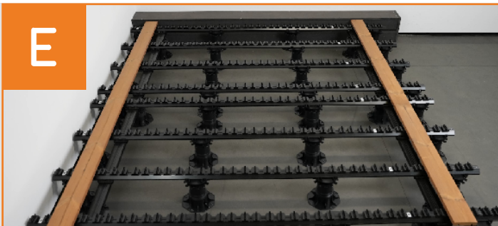
Erste und zweite Diele montieren
