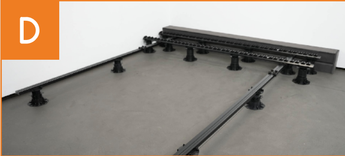
Systemschiene verlegen
