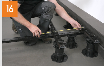
Systemschiene verlegen
