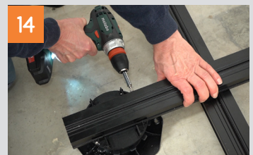
Terrassenlager mit Schienen verschrauben und Wand-Fix setzen
