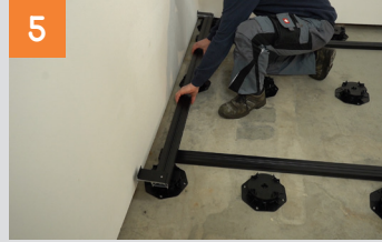
Schienen aufklicken und Abstände auf Plattenbreite ausrichten
