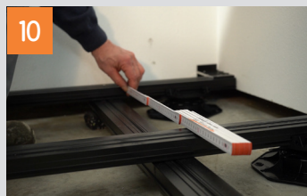
Unterkonstruktion in der Höhe ausrichten und mit der Konterlattung verschrauben
