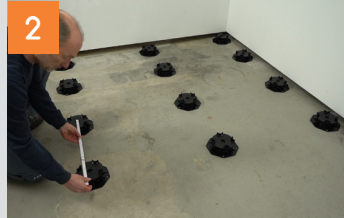
Terrassenlager aufstellen und Konterlattung auslegen
