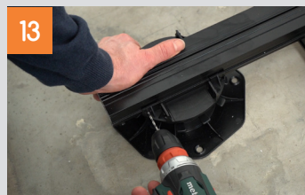
Terrassenlager mit Schienen verschrauben und Wand-Fix setzen
