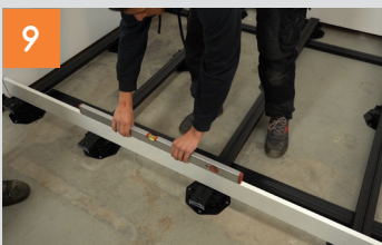
Unterkonstruktion in der Höhe ausrichten und mit der Konterlattung verschrauben
