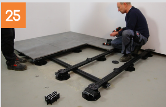
Verlegen der Platten in der Fläche
