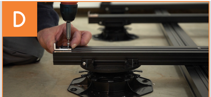
Terrassenlager mit Schienen verschrauben und Wand-Fix setzen
