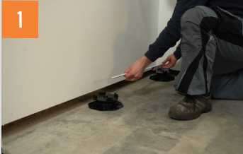
Terrassenlager aufstellen und Konterlattung auslegen
