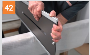
Vorbereiten und Montage eines Sichtschutzes in HPL mit Metall
