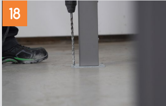
Montage der Mittel- und Endpfosten mit Hilfe von Schablonen
