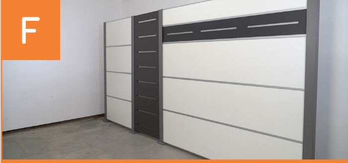
Montage Abdeckprofile auf die Pfosten
