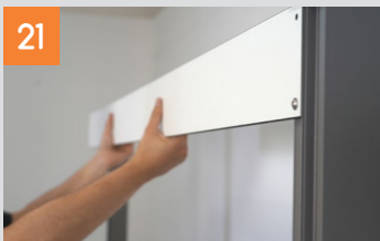
Montage der Abdeckkappen für Pfostenanker
