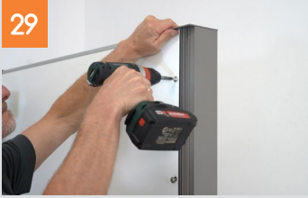
Montage der Kassetten
