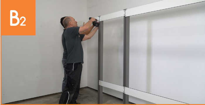
Montage der Mittel- und Endpfosten mit Hilfe von Schablonen
