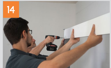
Montage der Mittelpfosten mit Hilfe von Schablonen
