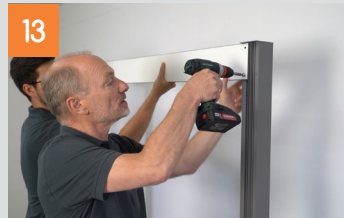
Montage der Mittelpfosten mit Hilfe von Schablonen
