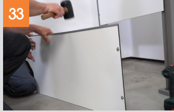
Montage der Kassetten
