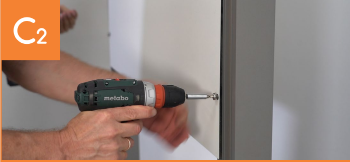
Montage der Kassetten
