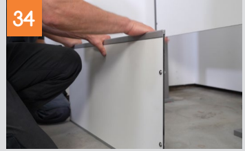
Montage der Kassetten
