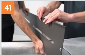
Vorbereiten und Montage eines Sichtschutzes in HPL mit Metall
