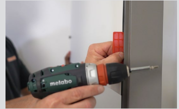
Alternativ: Montage der Pfosten mit Hilfe der Original-Kassetten
