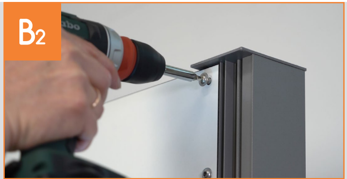
Montage der Mittelpfosten mit Hilfe von Schablonen
