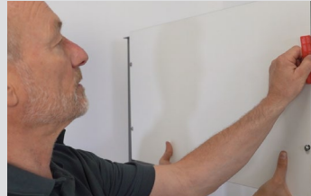
Alternativ: Montage der Pfosten mit Hilfe der Original-Kassetten
