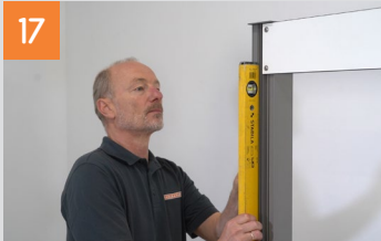
Montage der Mittel- und Endpfosten mit Hilfe von Schablonen
