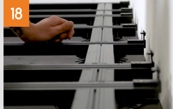
Montieren der ersten Diele
