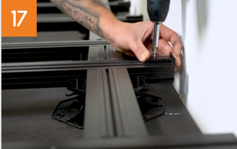
Montieren der ersten Diele
