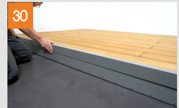
Seitenverblendung fertigstellen
