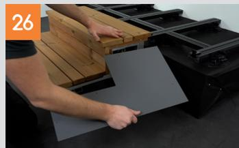
Messen Sie die Tiefe und Höhe der seitlich zu verkleidenden Fläche und übertragen die Maße auf die HPL Seitenverkleidung. Nach Zuschritt der Seitenverkleidung kann diese mit einer Holzschraube 4x25 mm an den Fixierungsleisten festschraubt werden.
