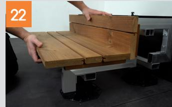
Trittstufen und Blenden müssen bauseits aus dem Dielenbelag der Terrasse konstruiert werden. Die Verschraubungspunkte der Fixierungsleisten unter den Dielen, die an der Außenseite der Wangen liegen, sind auf die Stufen-/Blendenmaße abzustimmen.
