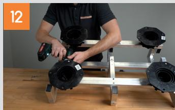
Nach dem gleichen Prinzip das Terrassenlager auf der anderen Seite der Strebe fixieren.
