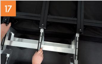
Ausrichten der Alu-Systemtreppe an der Unterkonstruktion der Terrasse.
