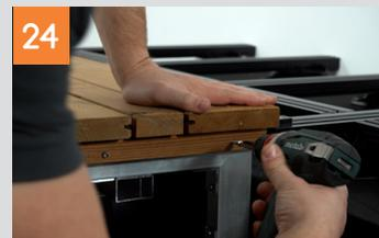
Nach dem Ausrichten muss diese an die Konstruktion geschraubt werden. Dazu mit einem 5 mm Bohrer die Fixierungsleisten vorbohren.
