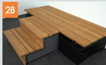
Falls nicht an eine bestehende Terrasse angebaut wird, kann anschließend der Deckbelag für die Terrasse verlegt werden.
