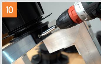
Erstes Terrassenlager an der Querstrebe anlegen, ausrichten und mit der Bohrschraube 3,9x16 mm festschrauben. Dabei in die vorgebohrten Löcher in den Querstreben schrauben.
