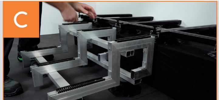
Aufschrauben der Systemleiste für Dielenverlegung
