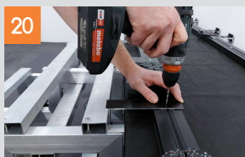
19 Alu-Systemtreppe in Längs- und Querrichtung ausrichten. Danach muss die Konstruktion mit der Terrasse oder dem angrenzenden Bauwerk fest verbunden werden. Zur Anbindung dient ein flaches Profil oder ein Winkel. Die Befestigung muss an die örtlichen Gegebenheiten angepasst und bauseits beschafft werden.
