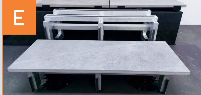
E Plattenbelag zuschneiden und verkleben
