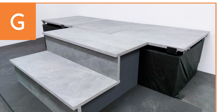
G Montage der Seitenverkleidung
