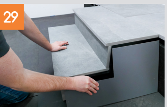
29 Messen Sie die Tiefe und Höhe der seitlich zu verkleidenden Fläche und übertragen die Maße auf die HPL Seitenverkleidung. Nach Zuschchnitt der Seitenverkleidung kann diese mit Bohrschrauben 3,9x16 mm an den Wangen festschraubt werden.
