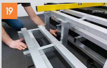
19 Alu-Systemtreppe in Längs- und Querrichtung ausrichten. Danach muss die Konstruktion mit der Terrasse oder dem angrenzenden Bauwerk fest verbunden werden. Zur Anbindung dient ein flaches Profil oder ein Winkel. Die Befestigung muss an die örtlichen Gegebenheiten angepasst und bauseits beschafft werden.
