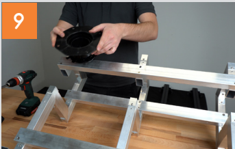
Fixieren der Terrassenlager
