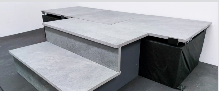
29 Messen Sie die Tiefe und Höhe der seitlich zu verkleidenden Fläche und übertragen die Maße auf die HPL Seitenverkleidung. Nach Zuschchnitt der Seitenverkleidung kann diese mit Bohrschrauben 3,9x16 mm an den Wangen festschraubt werden.
