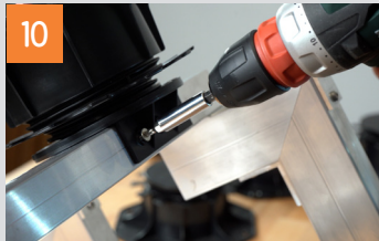
Fixieren der Terrassenlager
