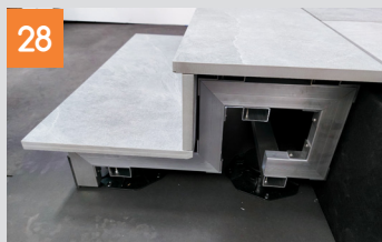
27 Überprüfen Sie die Tritthöhe und passen die Blenden aus dem bauseits vorhandenen Plattenbelag an. Kleben Sie das Fixierungsband in doppelter Stärke (4mm) direkt auf die Wange. Befestigen Sie dann die Blenden wie in Schritt 22 und 23 beschrieben.
