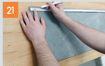
21 Zuschnitt der Trittstufen / Blenden erfolgt aus dem bauseits vorhandenen Plattenbelag. Überstand der Platte je Seite max. 6 cm (siehe Seite 4).
